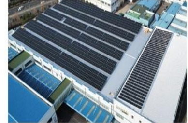
태양광 발전소 준공으로 전력량의 약 75%를 재생에너지로 대체하여 매년 556톤의 온실가스를 절감하는 효과로 탄소중립에 기여
