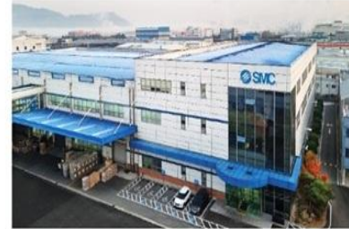
물류동 : 약 5,700평 (단납기 공급체제를 위한 재고보유) 제조동 : 약 6,400평, 제품생산 약 100만개/년
